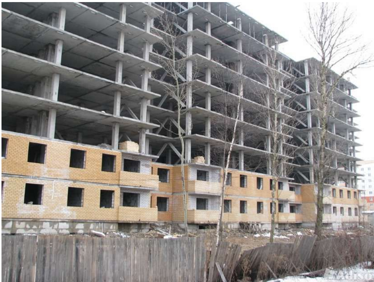
Рисунок 22 – Многоквартирный жилой дом, запроектированный по системе «КУБ – 2,5»
