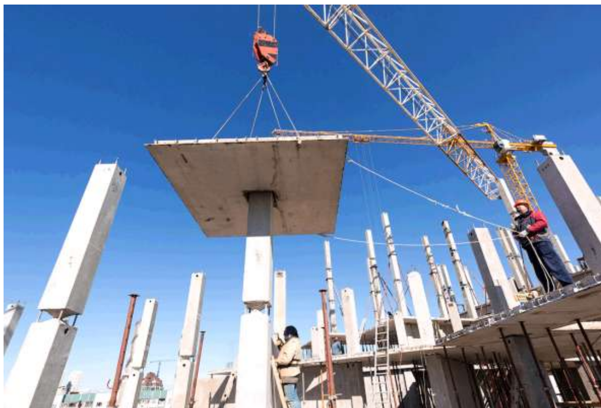
Рисунок 30 – Установка надколонной плиты перекрытия (НП)
