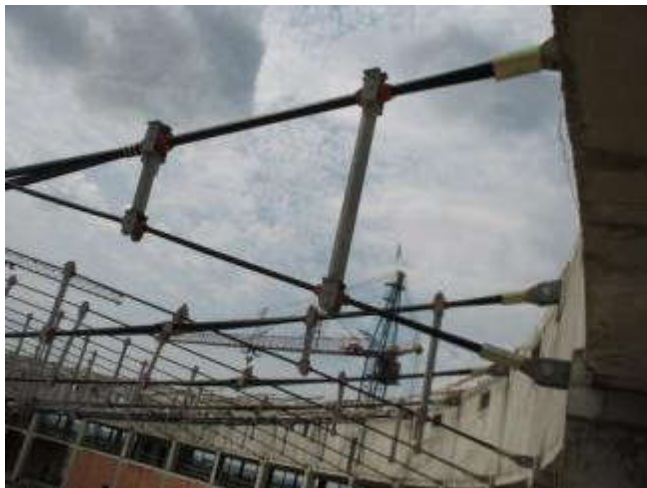
Рисунок 5.13 – Двухпоясное покрытие Минск Арена (Белоруссия,2010): а – общий вид покрытия; б- схема расположения вант; в– закрепление вант в опорном контуре;
